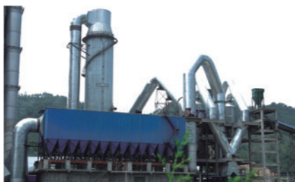
▲ 水泥厂窑头窑尾除尘 Cement Factory
